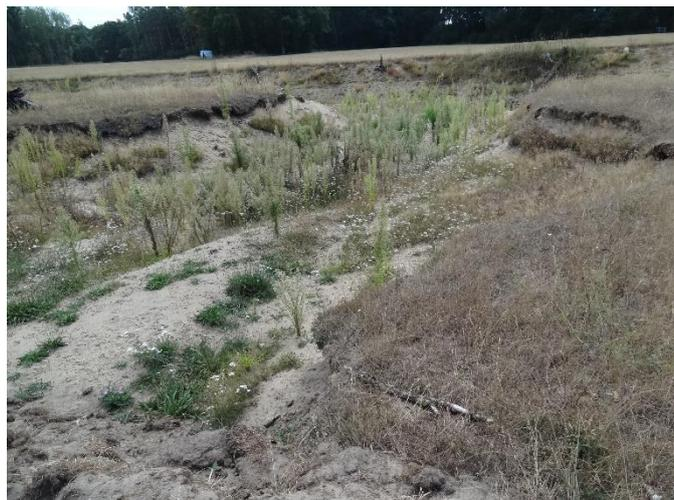
Abbildung 28: Seitlich eingespülter Boden in die Flutmulde in der östlichen BIMA-Fläche (31.07.2018)
