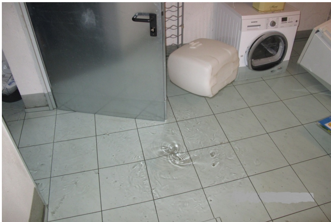
Abb. 13: Wasserrohrbruch in Gebäude (Foto Feuerwehr Rastatt)
